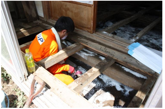
家屋の片付け、床下の泥出し作業
